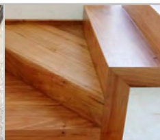
ENTREPISOS, ESCALERA Y BARANDAS
