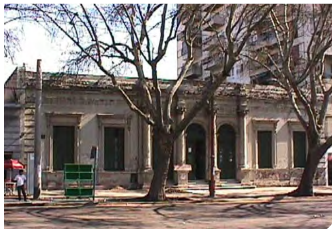
Vista previa a la intervención (2003).
