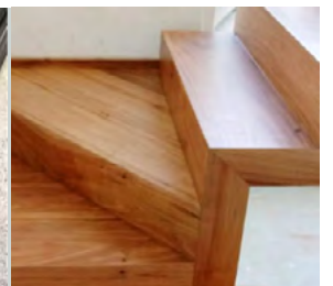
ENTREPISOS, ESCALERA Y BARANDAS
