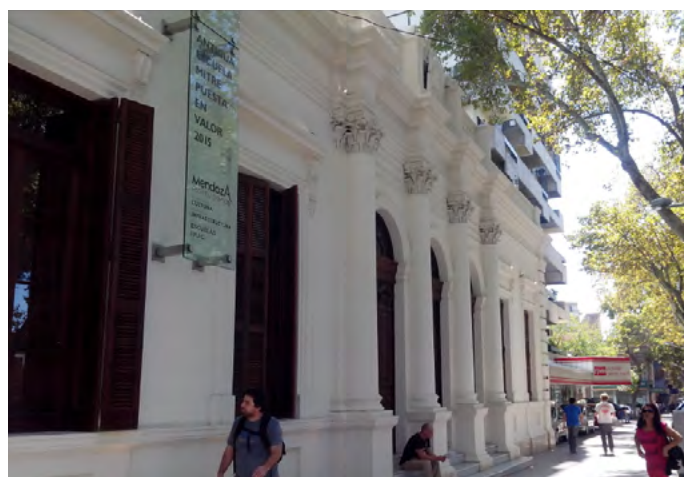
Detalles de la fachada
