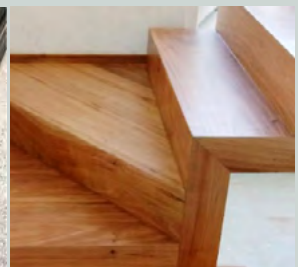
ENTREPISOS, ESCALERA Y BARANDAS
