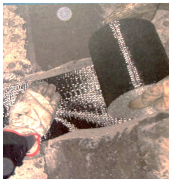
Consolidación con malla fibra de carbono en bóveda de ladrillos.
