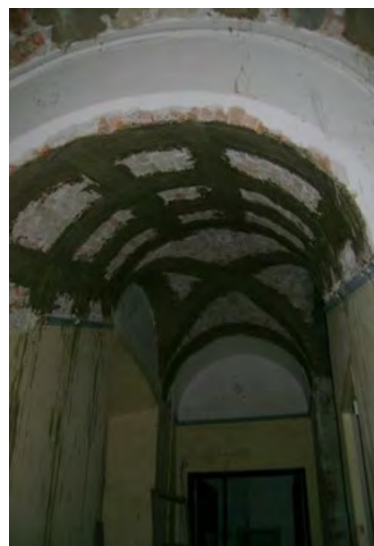
Refuerzo con fibras de carbono y mortero epoxi.
