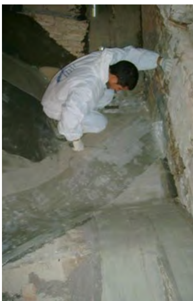
Refuerzo bóveda con fibra de vidrio.
