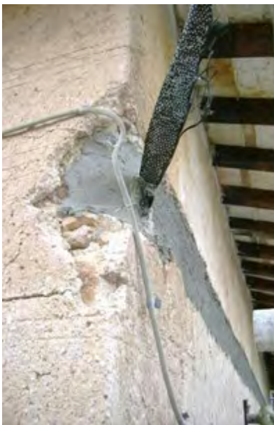
Consolidación con fibra de carbono.
