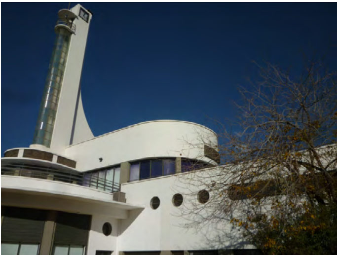
Vista de terraza y escaleras externas. (2015)
