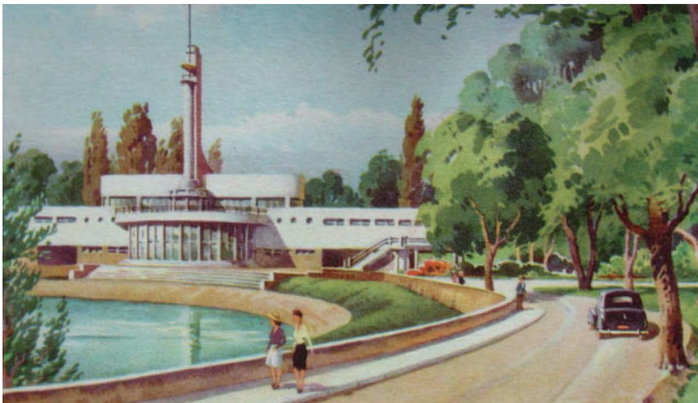
Postal coloreada. Vista del edificio y su entorno.
