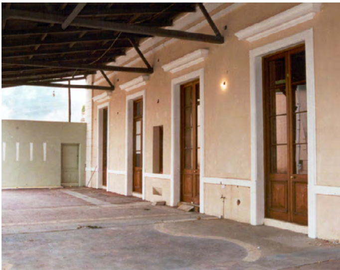
Vista de galería sur (2002).
