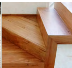
ENTREPISOS, ESCALERA Y BARANDAS
